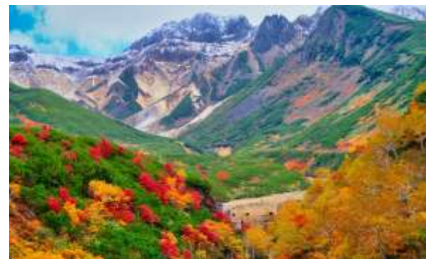
十勝岳とヌッカクシ富良野川上流の砂防堰堤
