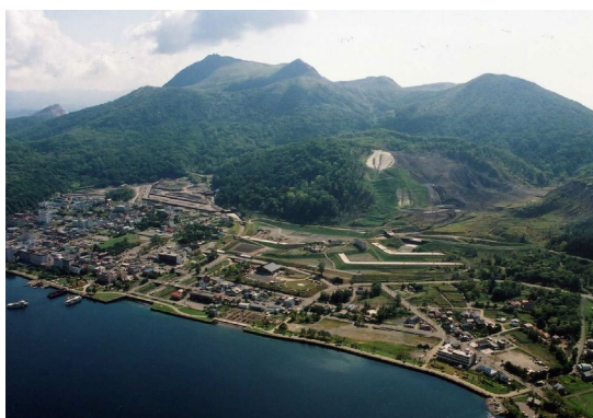
有珠山と洞爺湖温泉街を守る砂防施設
