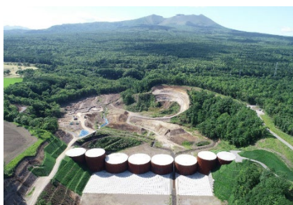
樽前山 覚生川砂防堰堤
