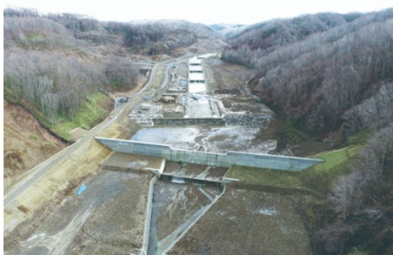
地震後の土砂災害対策施設(日高幌内川)
