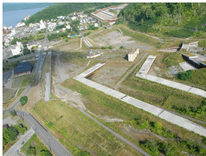
有珠山 西山川砂防堰堤
