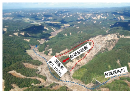
日高幌内川 大規模斜面崩壊と河道閉塞状況
