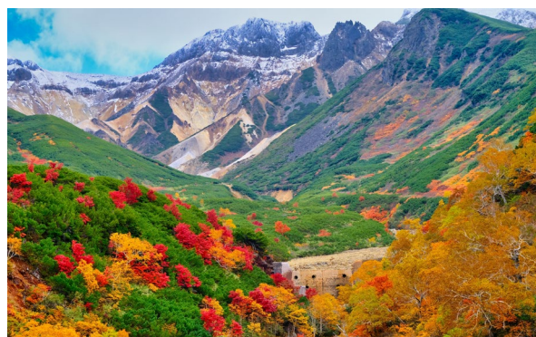
十勝岳とヌッカクシ富良野川上流の砂防堰堤
